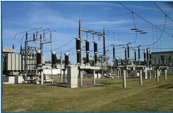
Dann kommt der Strom ins Umspannwerk. Hier wird er auf Hochspannung umgelegt. So ist eine Verteilung des Stroms über ganz Österreich möglich.
