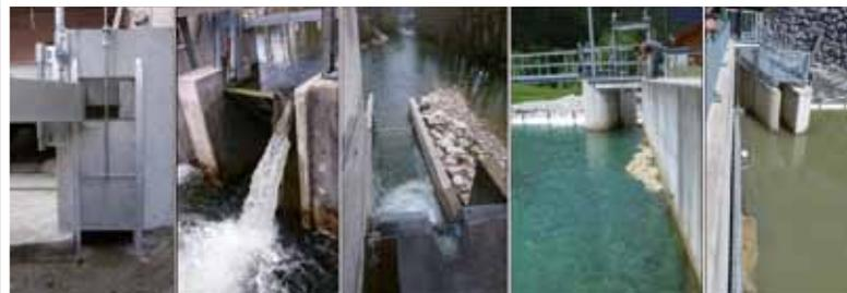
1) oberflächen- und sohnnahe Öffnungen zum Turbinen-Bypass (Standort Thaya). 2) Abstiegsklappe an der Seeache. Bei Betrieb der Rechenreinigung wird die gesamte Klappe zum Ableiten des Treibgutes abgesenkt. 3) Abstiegsklappe ebenfalls an der Seeache in ähnlicher Ausführung. 4) Zulauf zur Abstiegs-/Restwasserklappe an der Kleinarler Ache. Die Öffnung ist am Gewässerrand situiert. 5) Oberwasserbereich mit Abstiegs-/Restwasserklappe am Fritzbach. Die Abstiegsklappe ist vom Gewässerrand versetzt.
